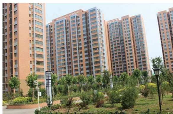
和谐家园 A 区公租房建设项目
